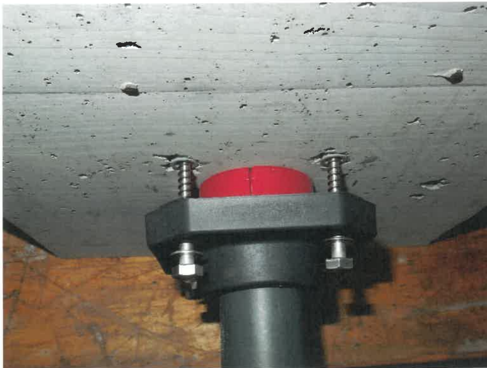
Bild 2 Applikation der Sparten-Hauseinführung S-HEF
