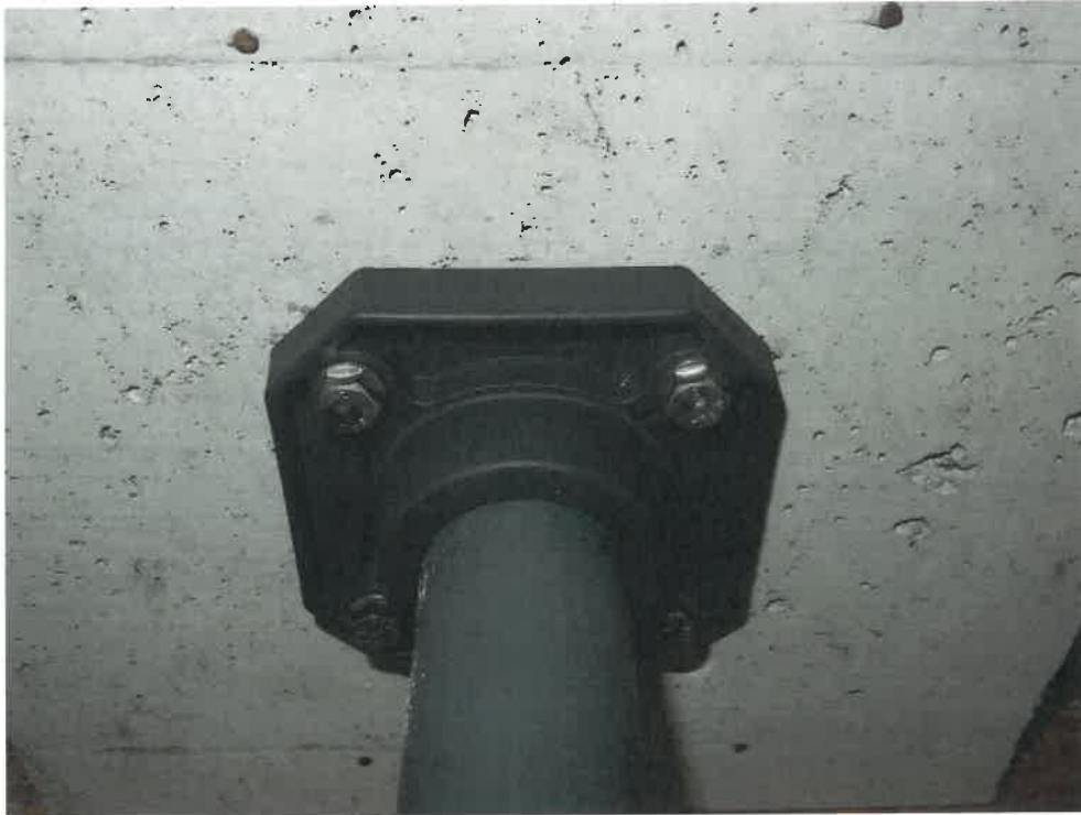
Bild 3 Applikation der Sparten-Hauseinführung S-HEF
