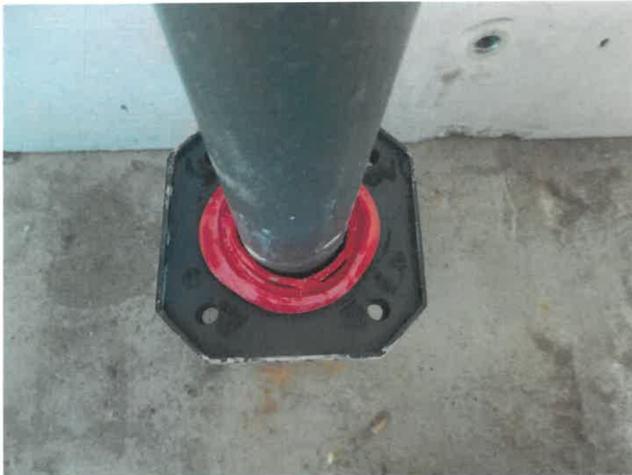
Bild 9 Segmentring-Dichteinsatz nach der Prüfung der Gasdichtheit
