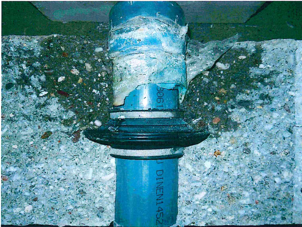
Bild 7: ebenda; Prüfkörperhälfte mit eingebundenem Rohr
